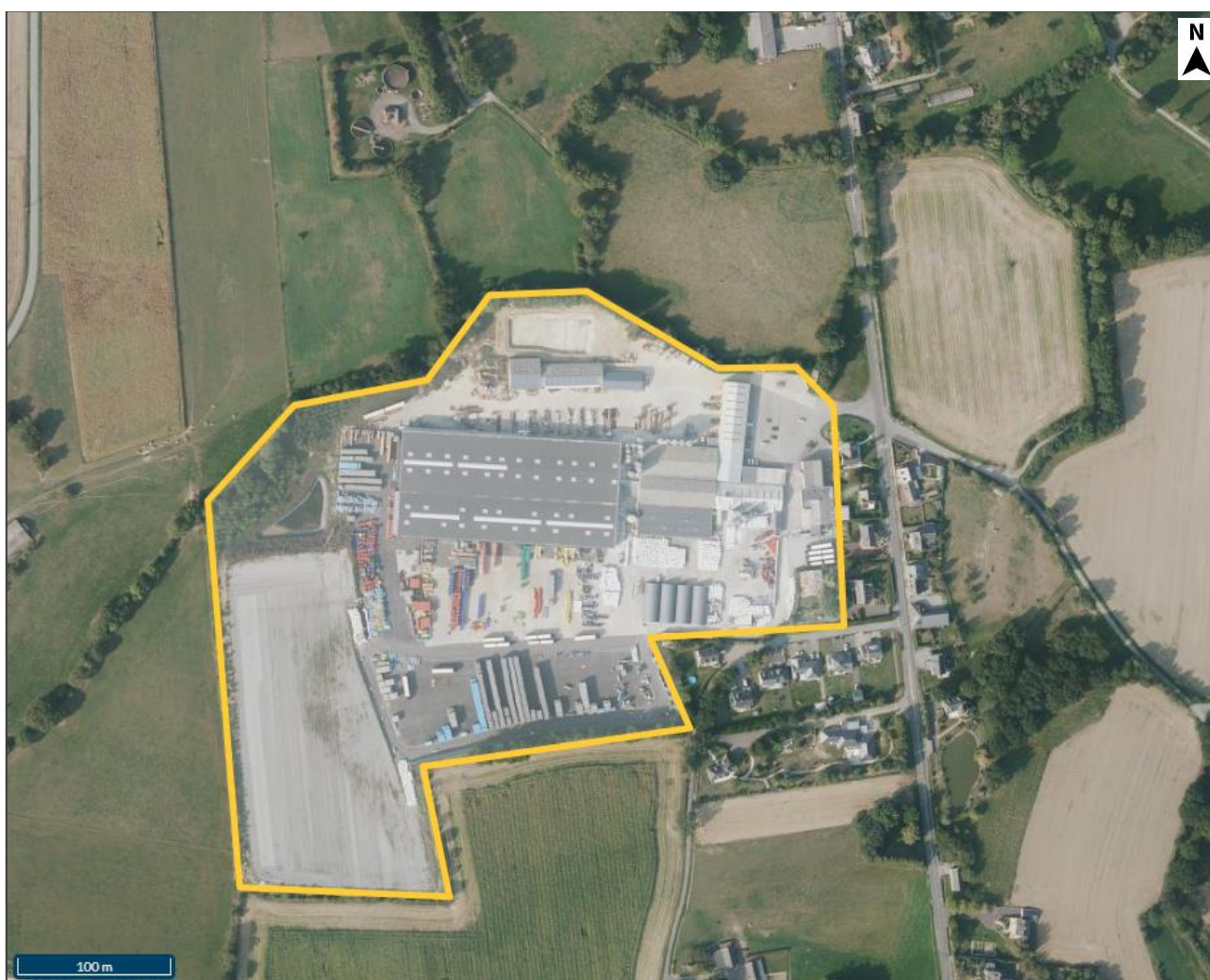
Localisation du site dans son environnement
