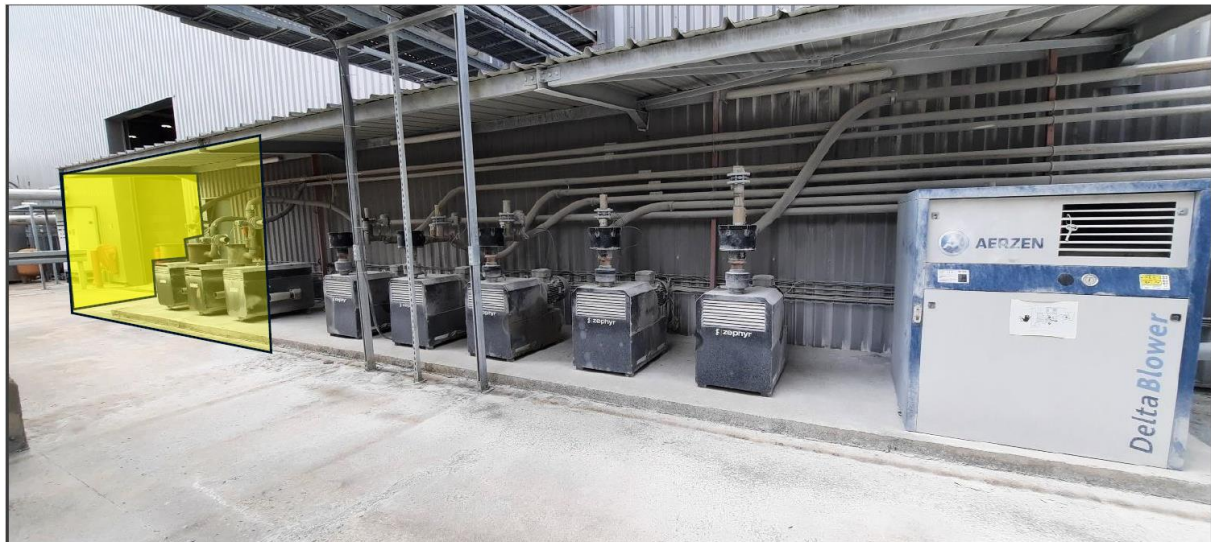
Figure 23 : Mur acoustique prévu (Source : Venathec)
