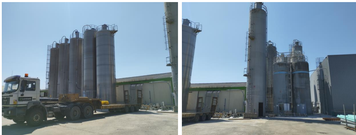
Figure 84 : Photos des silos
