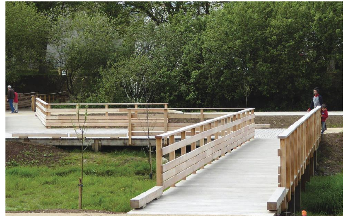
Exemples de platelage au droit d'une zone humide
