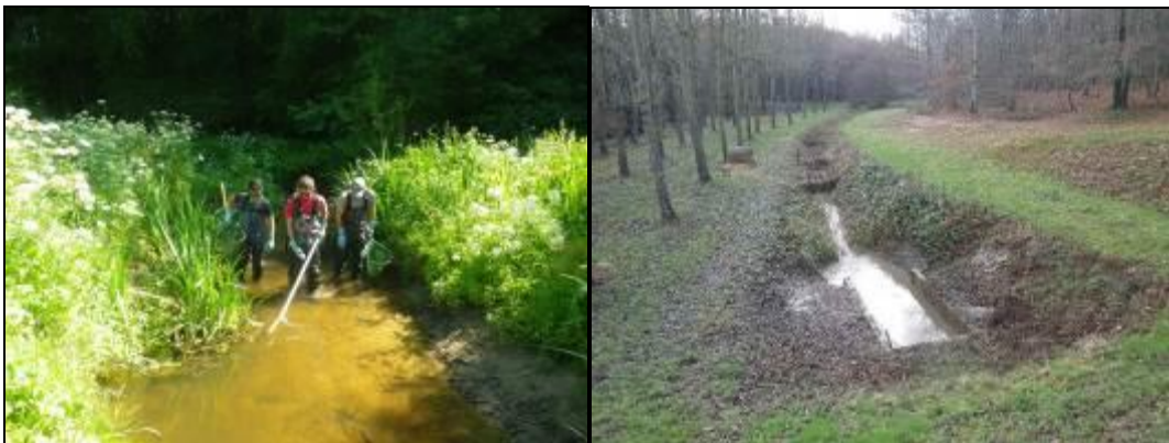
Action de pêche électrique sur le Loc'h et mise en place de filtres à paille en amont d'une zone de travaux sur le Long
