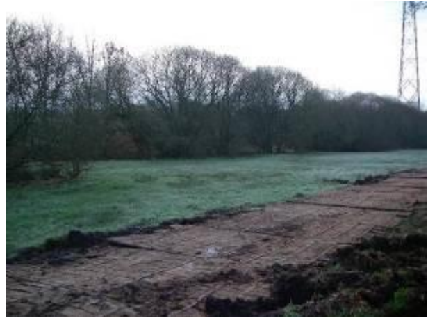
Exemple d'un cheminement provisoire en bois qui protège le sol de la parcelle (bassin du Rion, chantier ERDF)
