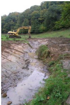
Restauration du gabarit originel du cours d'eau
