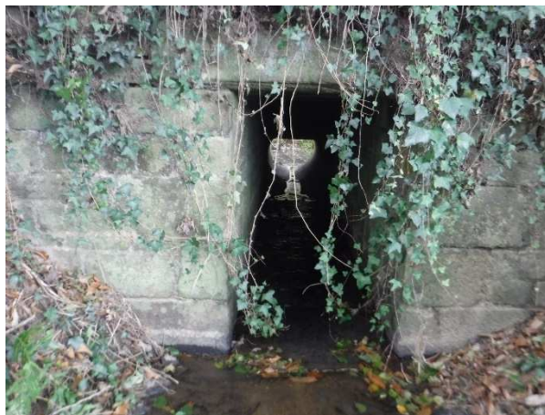
Entrée du pont au niveau de la digue
