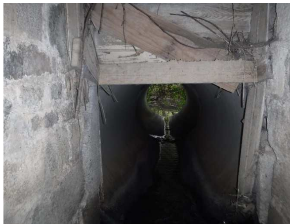
Jonction entre le pont et le busage
