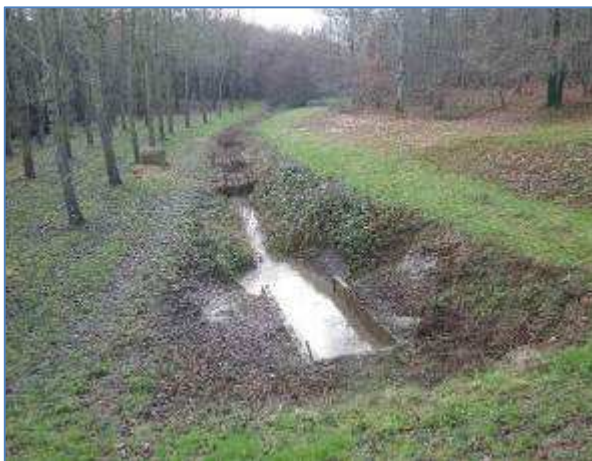
Figure 30 : Exemple de mise en place de bottes de paille dans le lit de la rivière le Long (37), à l'aval d'un étang lors de sa vidange
