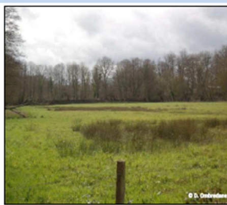
2 : vue de la parcelle située à l'amont de la digue où sera construit le pont cadre
