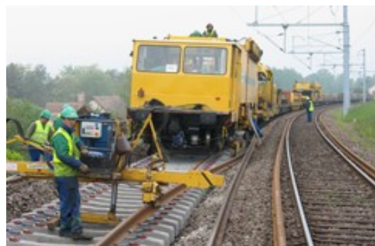
Longs Rails soudés sur traverses béton
