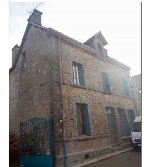
Fig.225 : Maison rue de la Garenne
