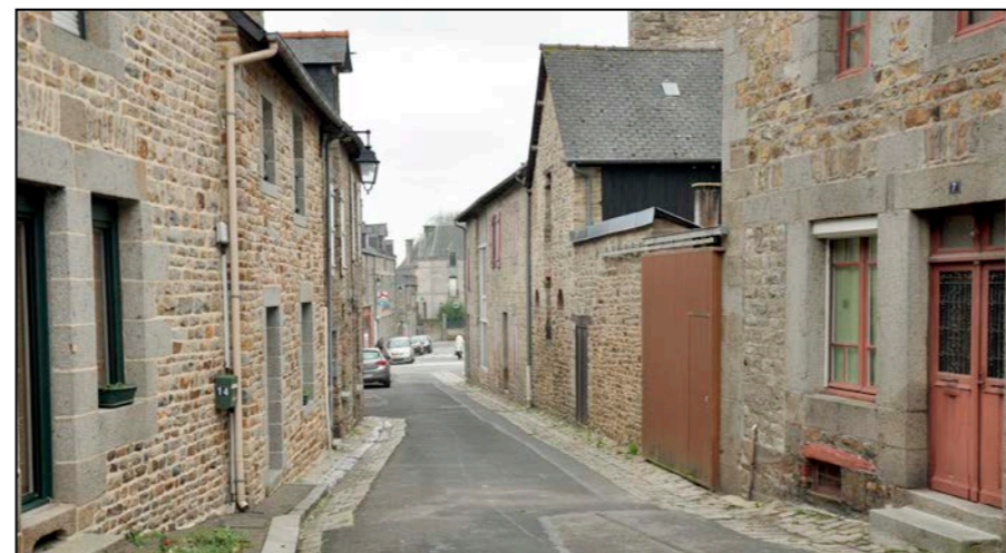
Fig. 123 : Rue Édouard Pontaille
