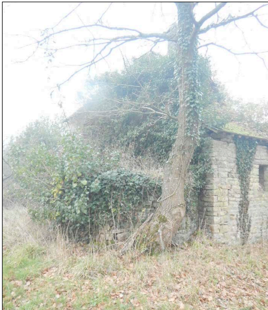
Fig.252 : bâtis d'accompagnement anciens fours sur le lieu-dit les Vallées
