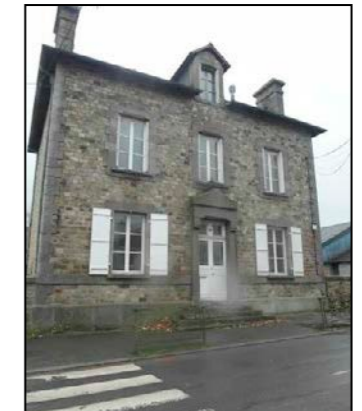
Fig.204 : École de garçons (rue Leclerc), 1884
