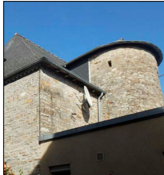
Fig.259 : Vestige d'une tourelle d'escalier, rue du Pavement
