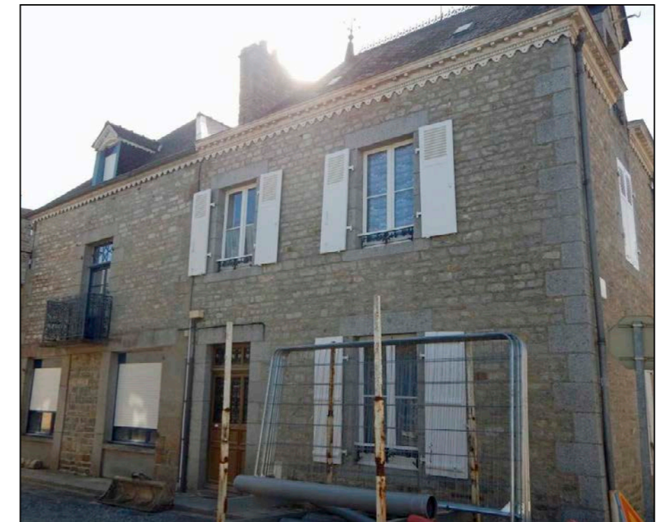
Fig.226 : Maison rue de la Garenne / rue du Pont Joachim
