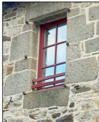
Fig.269 : Encadrement cintré ; pierre de taille de granit chanfreiné
