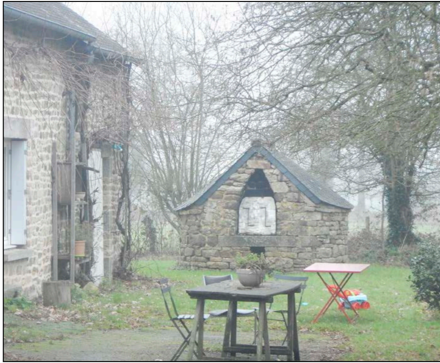
Fig.251 : bâtis d'accompagnement anciens fours sur le lieu-dit les Vallées
