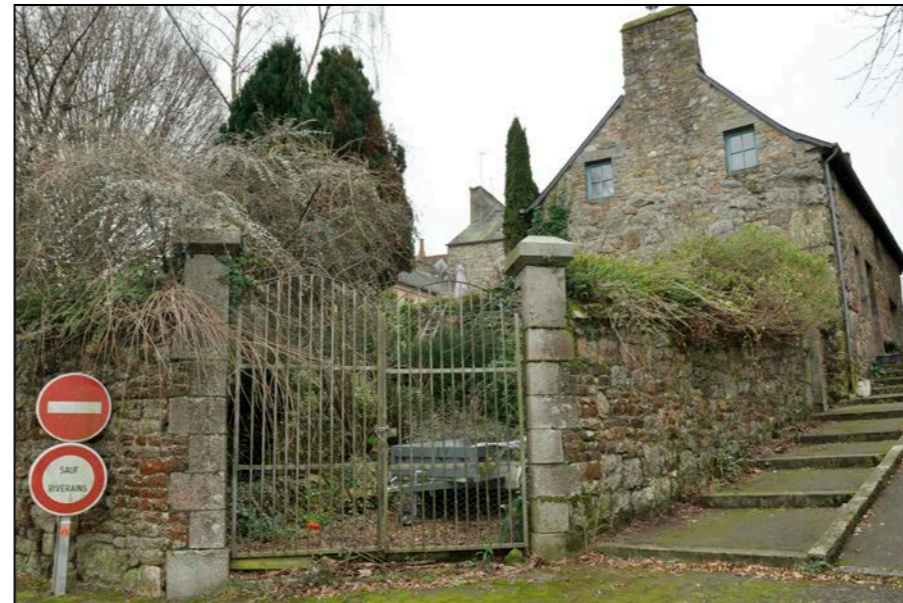
Fig.138 : Portail à l'angle du chemin des Douves et de l'impasse de la Grande Roche
