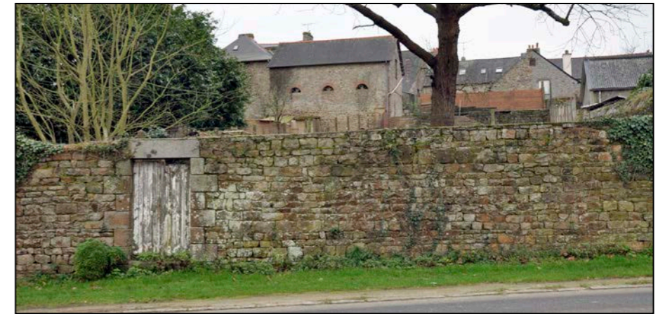
Fig.134 : Mur de clôture route de Fougères
