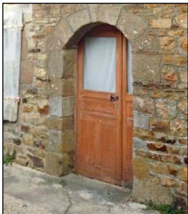
Fig.269 : Encadrement cintré ; pierre de taille de granit chanfreiné
