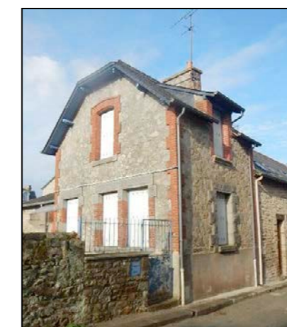
Fig.227 : Maison rue de la Garenne / rue du Pont Joachim
