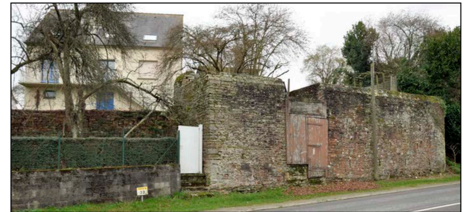
Fig.135 : Mur de soutènement route de Fougères
