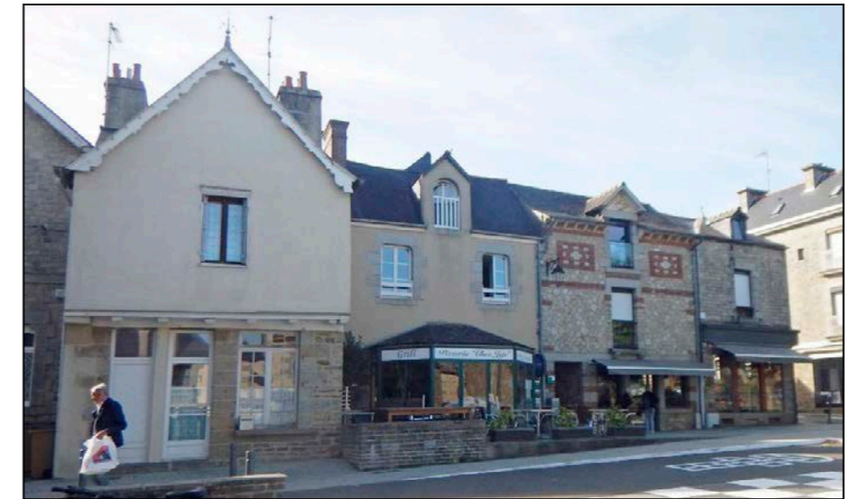
Fig.188 : Front bâti frappé d'alignement au sud-ouest de la place Alexandre Veillard
