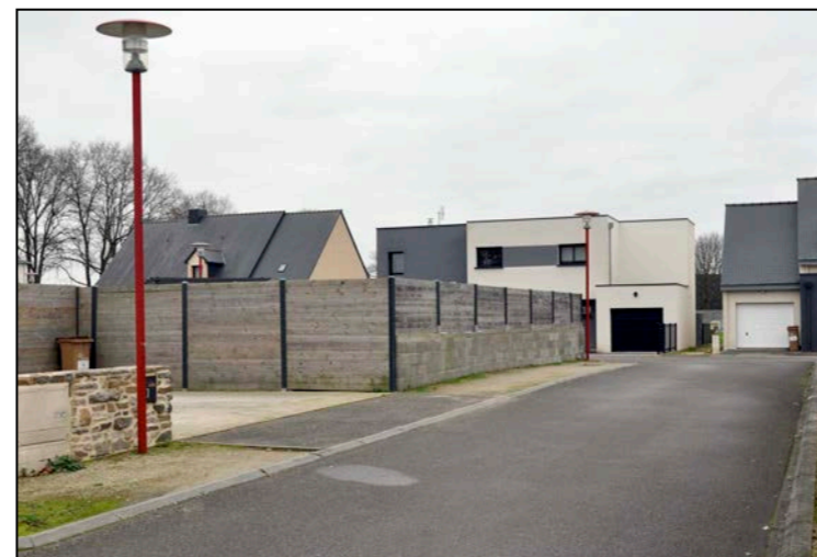
Fig. 143 : Maison à toits plats, rue du bourg au Loup
