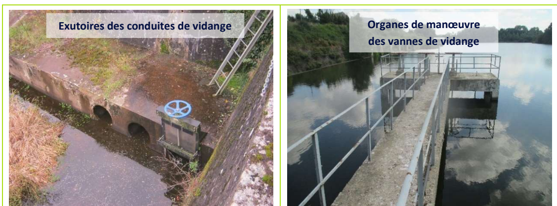
Figure 5 : Barrage de Pont-Avet – Photographie des exutoires de conduites de vidange et des vannes de vidange
