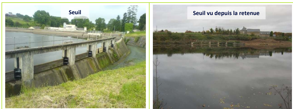
Figure 25 : Barrage de Pont-Avet – Photographies du seuil
