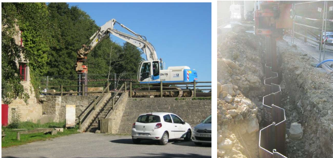
Figure 6 : Exemple de mise en œuvre d'un écran étanche par rideau de palplanches – Barrage de Pen Mur (56) – MOE SAFEGE - 2015
