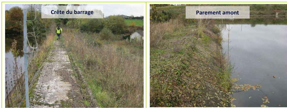
Figure 3 : Barrage de Pont-Avet – Photographie de la crête et du parement amont
