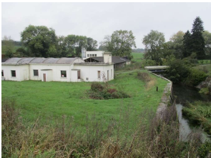
Figure 50 : Végétation rase du parement aval (avant travaux d'entretien)
