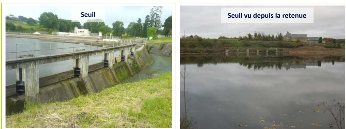
Figure 4 : Barrage de Pont-Avet – Photographies du seuil
