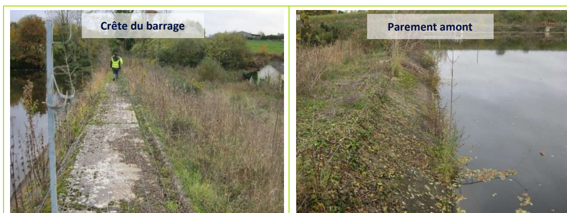
Figure 24 : Barrage de Pont-Avet – Photographie de la crête et du parement amont
