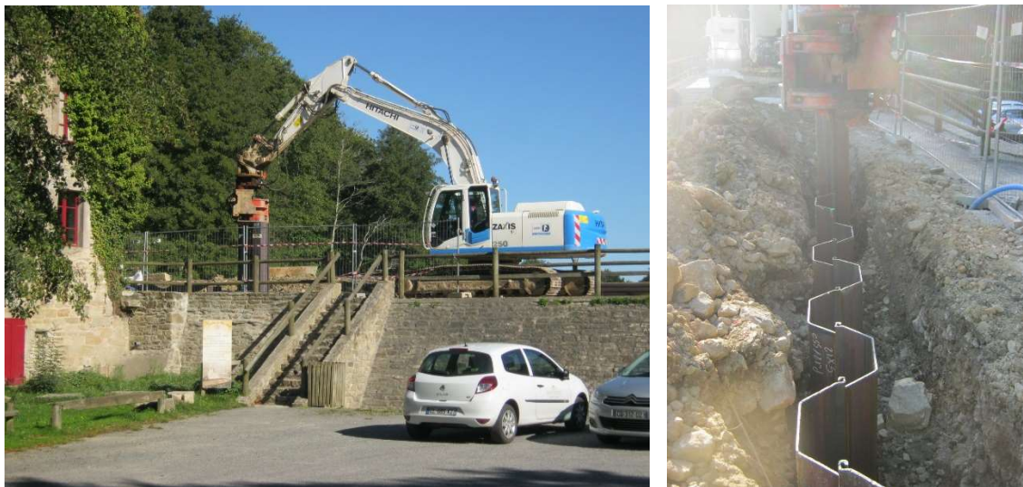
Figure 29 : Exemple de mise en œuvre d'un écran étanche par rideau de palplanches – Barrage de Pen Mur (56) – MOE SAFEGE - 2015
