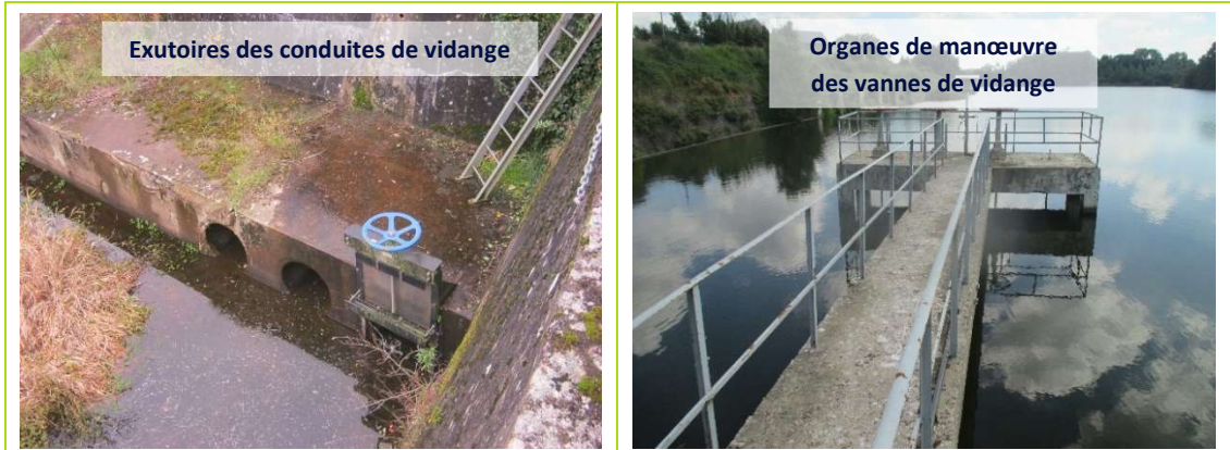
Figure 26 : Barrage de Pont-Avet – Photographie des exutoires de conduites de vidange et des vannes de vidange
