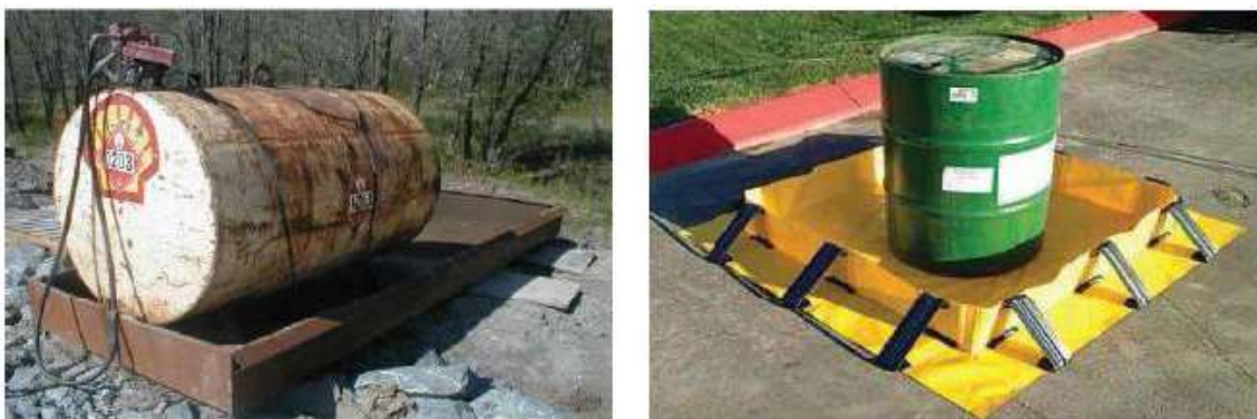
Figure 8 : Stockage imperméabilisé
