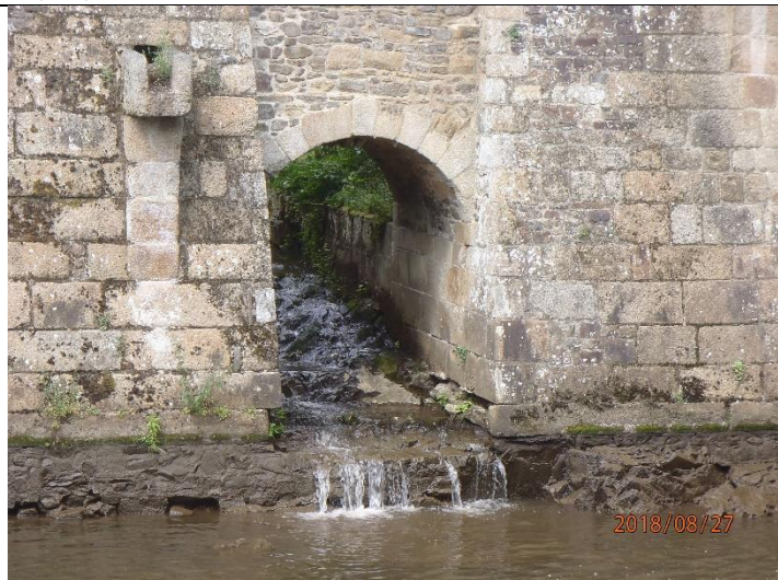
Exutoire du canal de décharge du seuil « cascade » après test d'abaissement du 27/08/2018
