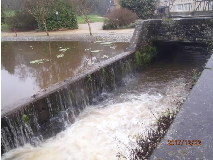
Seuil de décharge à araser de 25cm
