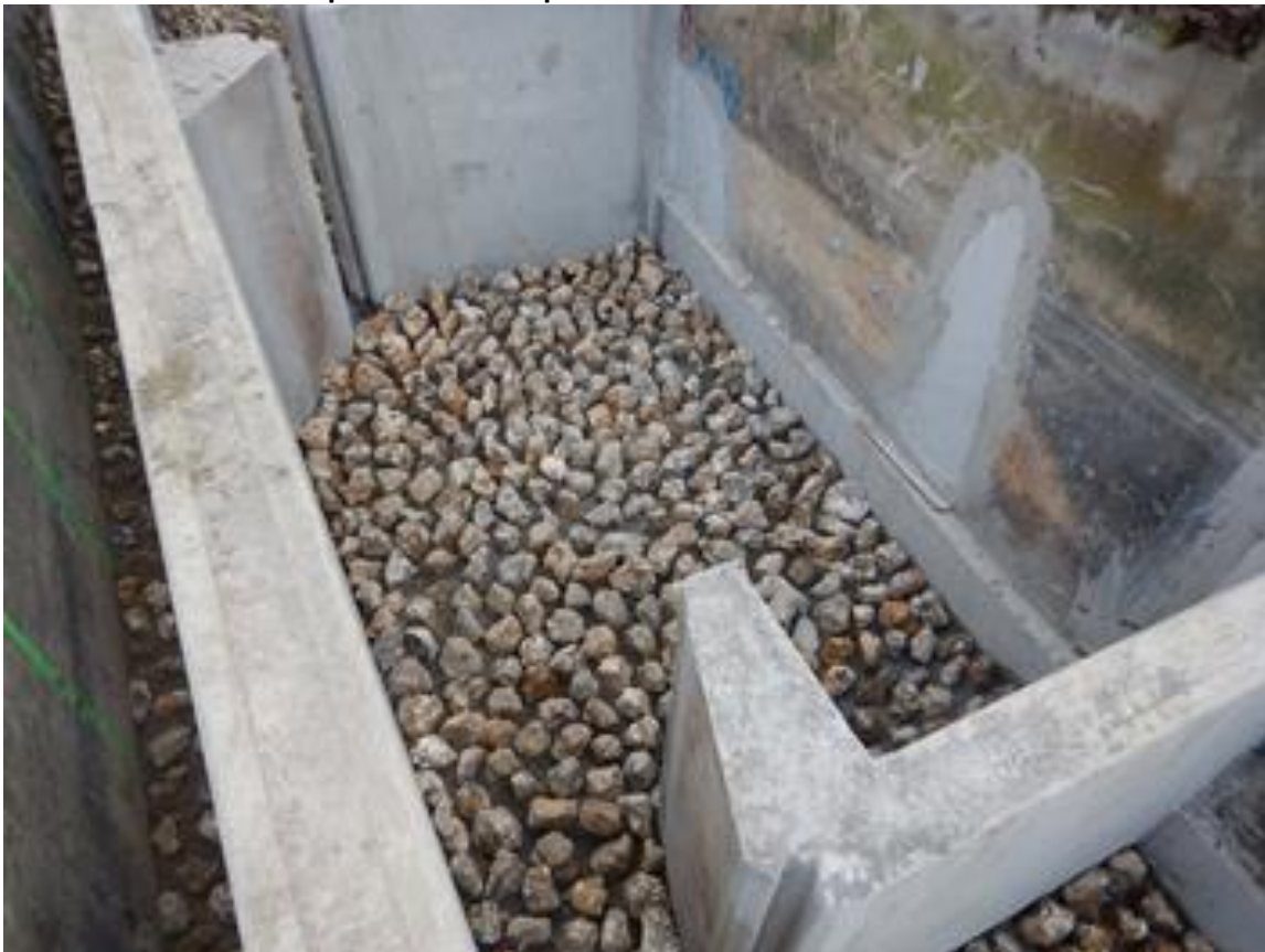
Exemple de rugosité de fond de bassin
