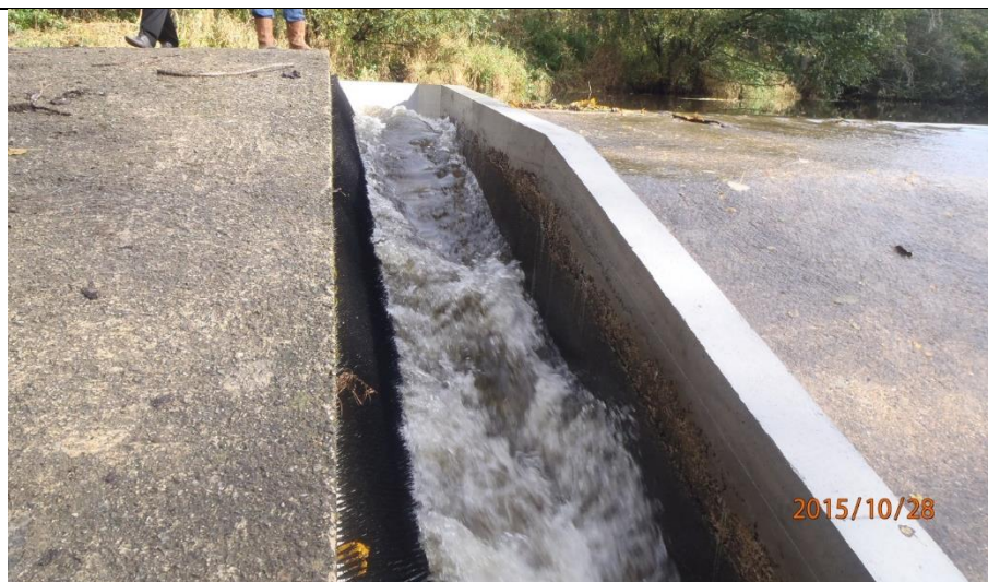
Exemple de passe à ralentisseurs avec substrat de reptation
