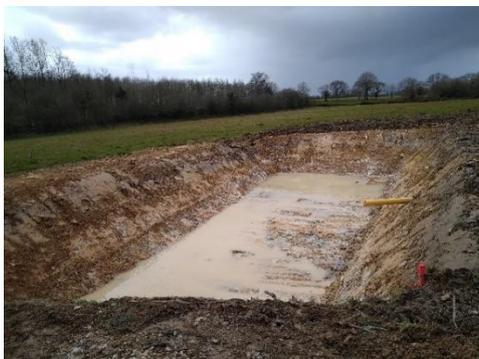
Illustration d'une ZTE récoltant les eaux de drainage avec un exutoire par surverse vers une zone enherbée humide – Source ; Hardy Environnement
