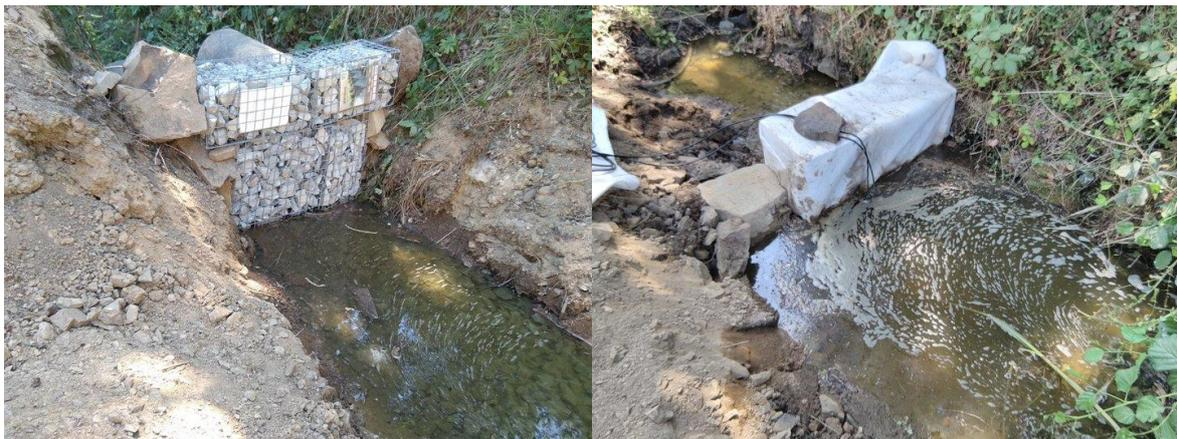
Figure 51 : Exemple de filtre avec gabions et géotextile installés sur le ruisseau en aval des étangs de Darancel à Saint Médard-sur-Ille lors des travaux de suppression de ces étangs réalisés en 2022
