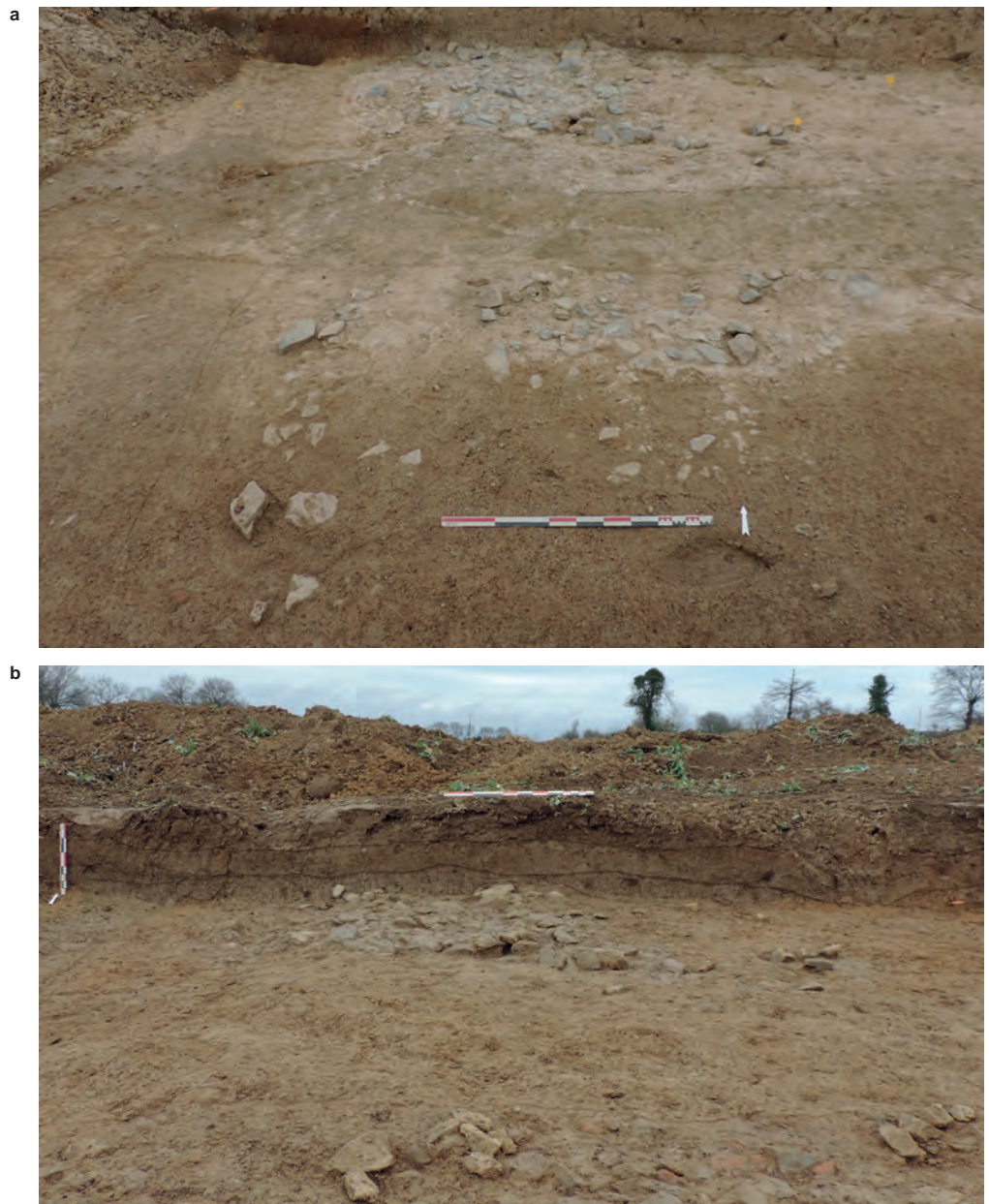
Fig. 44a et b- Vues vers le nord, en plan et en coupe, du chemin 419, tranchée 17.
