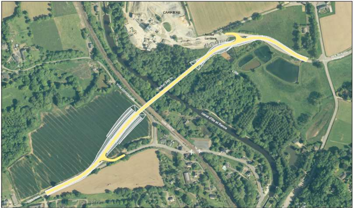
Vue aérienne du viaduc
