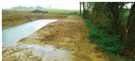
Nouveau bassin de décantation en sortie de drains photo DDTM35 - SEB
