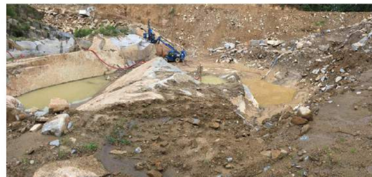
7726 - les bassins de récupération d'eau en cascade
