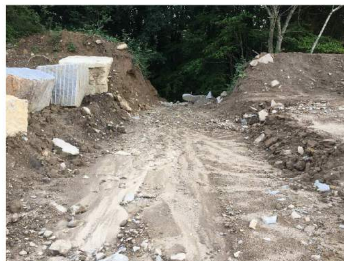
7728 - évacuation de l'eau depuis la plateforme vers le bois puis vers le ruisseau des Echelles au Nord
