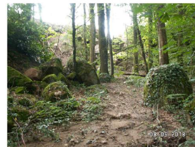
l'évacuation de l'eau depuis la plateforme vers le bois forme une coulée de boue lors des forts épisodes pluvio-orageux
