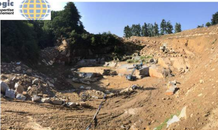
7712 - vue générale de la carrière vers le Sud (extraction actuelle)
