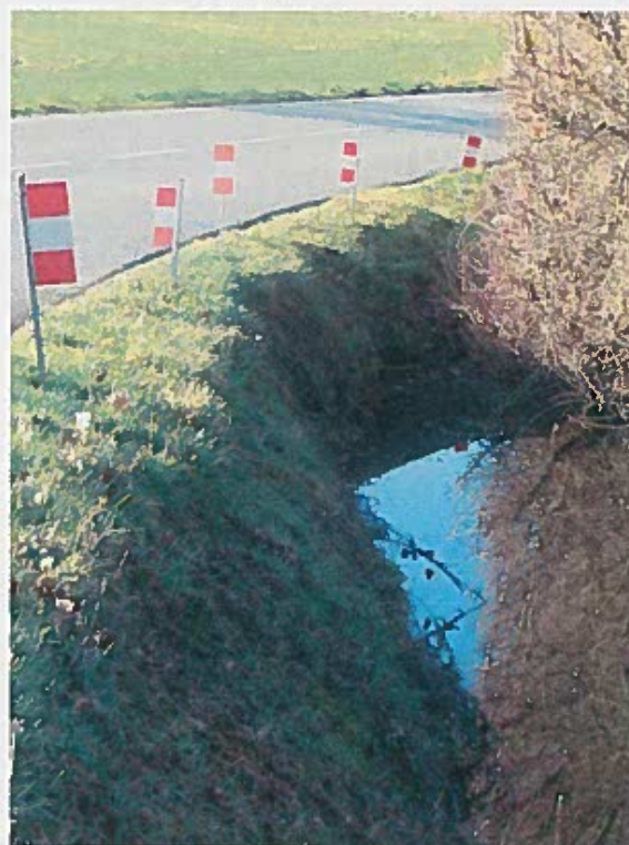
Erosion de la berge rive droite du plan d'eau (Photo du 24 janvier 2019)
