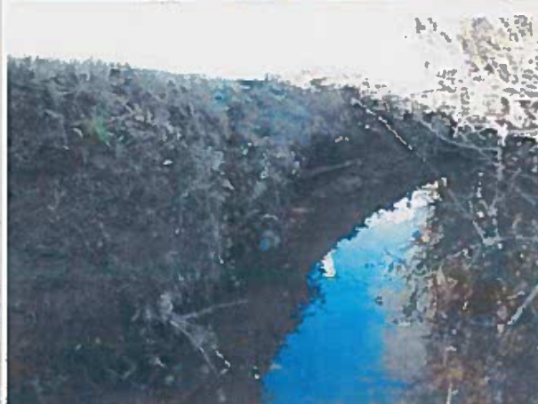
Mise en évidence du phénomène de renard sous l'accotement de la route départementale (janvier 2019)
