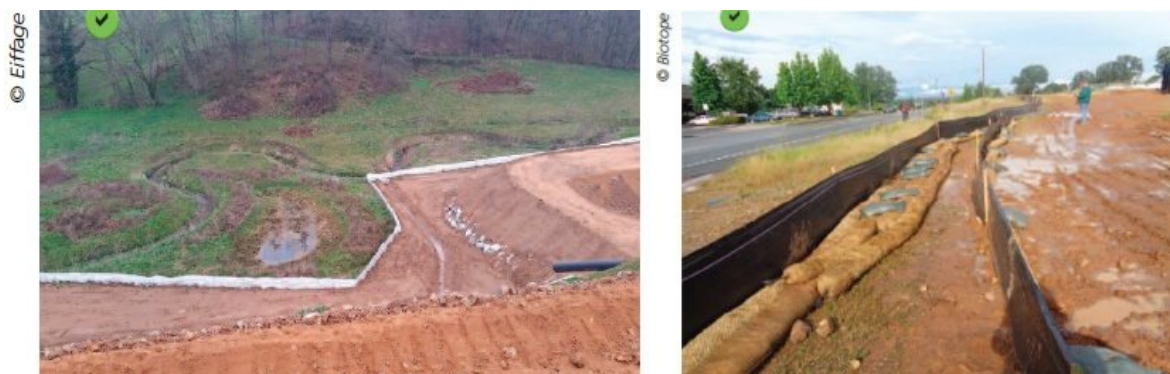
Figure 12 : A gauche : Barrière de rétention longeant un cours d'eau. A droite : Double barrières de rétention installées à la périphérie de l'emprise du chantier et conjuguées à des boudins en fibres de paille maintenus au sol par des sacs de graviers.
