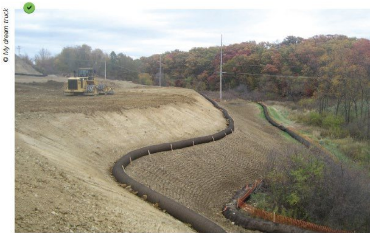
Figure 3 : Approche multi-barrières appliquée à un talus décapé : lutte contre l'érosion par chenillage des sols, infiltration des écoulements superficiels à l'aide de boudins de rétention en série, maintien d'une zone tampon entre le chantier et le cours d'eau par mise en défens de la ripisylve (source : Guide technique AFB « Bonnes pratiques environnementales – Protection des milieux aquatiques en phase chantier », 2018)
