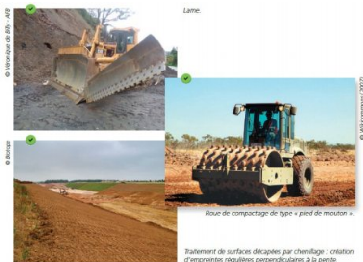
Figure 6 : Engins utilisés pour la création de microreliefs (source : Guide technique AFB « Bonnes pratiques environnementales – Protection des milieux aquatiques en phase chantier », 2018)
