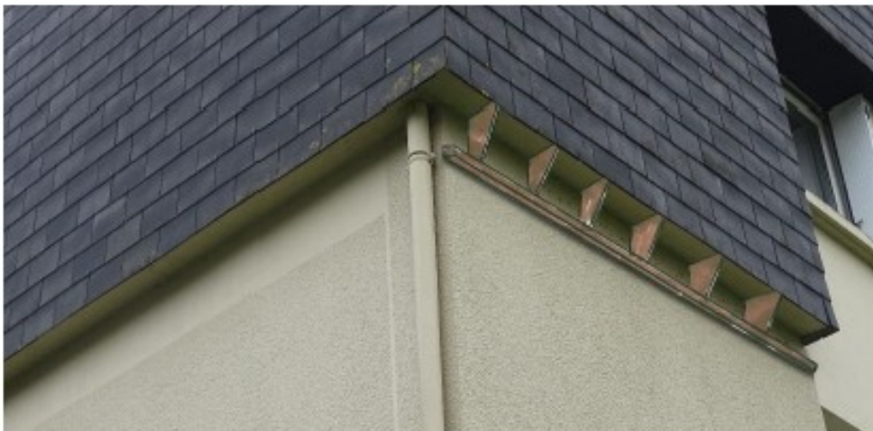
Figure 7 : Montage photographique du système « point d'accroche » pour faciliter l'installation des nids naturels des hirondelles de fenêtre
