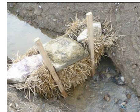
Emplacement de bottes de paille en phase travaux, dans un bassin d'orage et un cours d'eau
