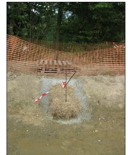
Emplacement de bottes de paille en phase travaux, dans un bassin d'orage et un cours d'eau
