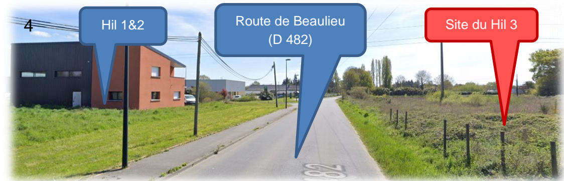
Figure 133 : photo de la route de Beaulieu au nord-est du Hil 3
