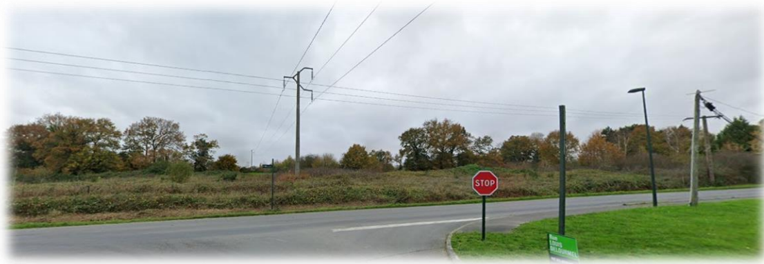
Figure 115 : vue de la ligne Haute tension depuis la rue de Beaulieu
