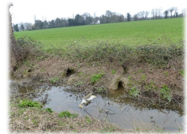
Figure 175 : Exemple d'un réseau de galeries présent sur le site
