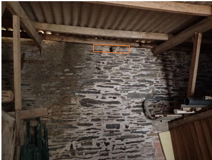
Exemple d'ouverture à créer à partir du bâtiment à utiliser comme passerelle (Source : CERESA, 02-03-2023)
