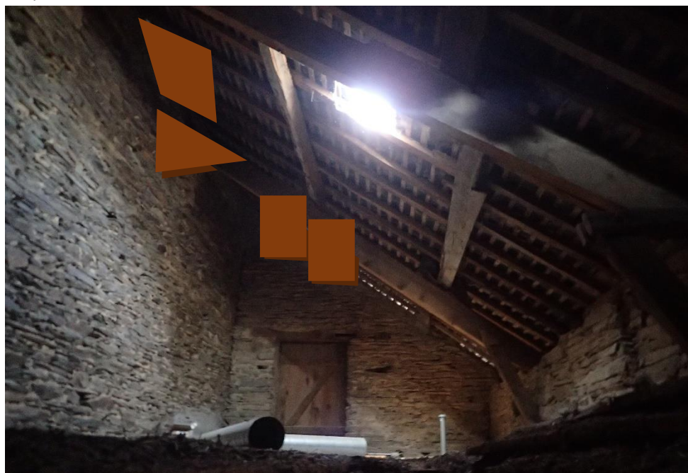
Exemple d'interstices à aménager dans le comble Nord (source : CERESA)
