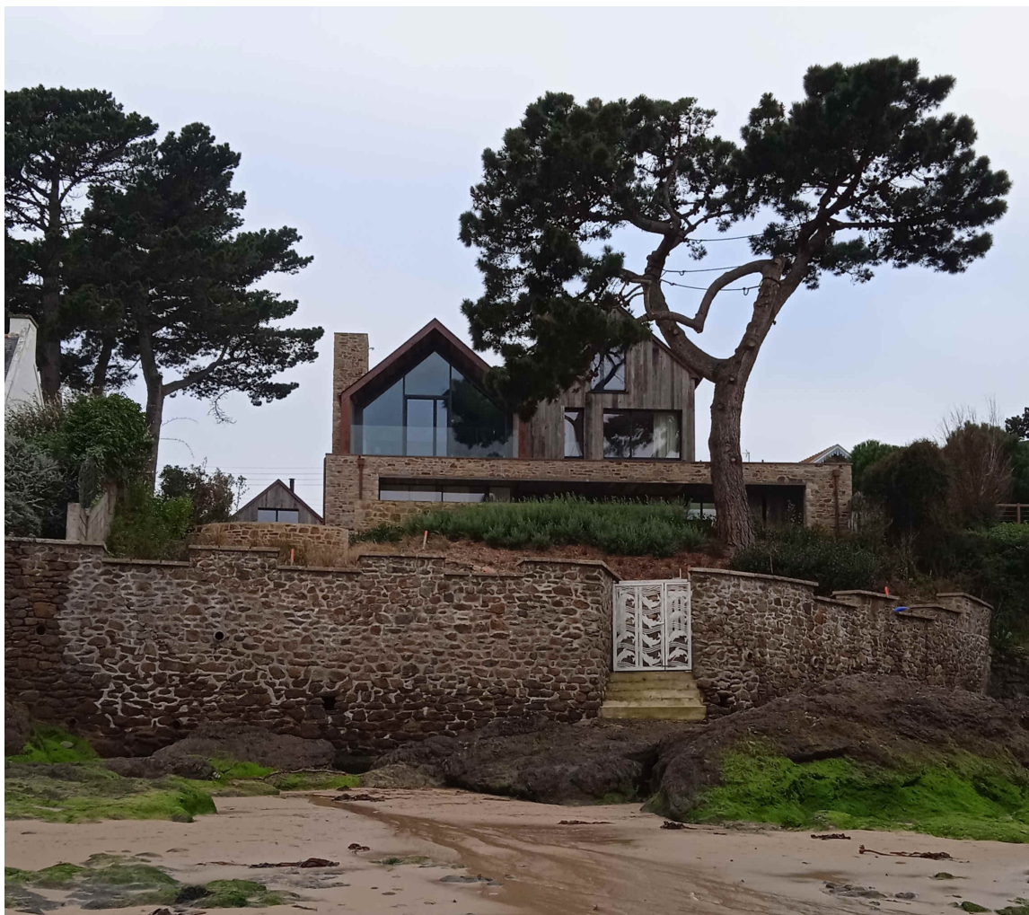
Mur de clôture et escalier d'accès à la plage du Havre de Rothéneuf au droit de la parcelle cadastrée P 330
