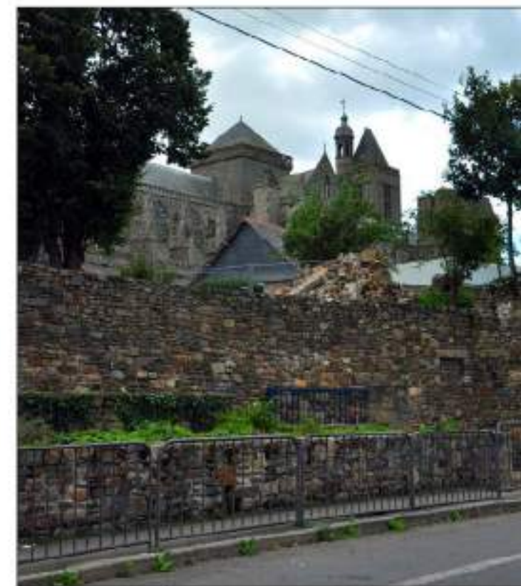
Fig. 92 : Mur de soutènement rue des Murets
