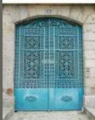
Fig. 358 : Grille en fer forgé, 21 Grande-Rue des Stuarts
