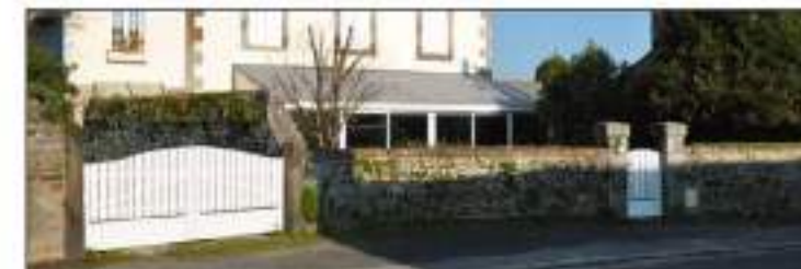
Fig. 97 : Muret rue de Paris
