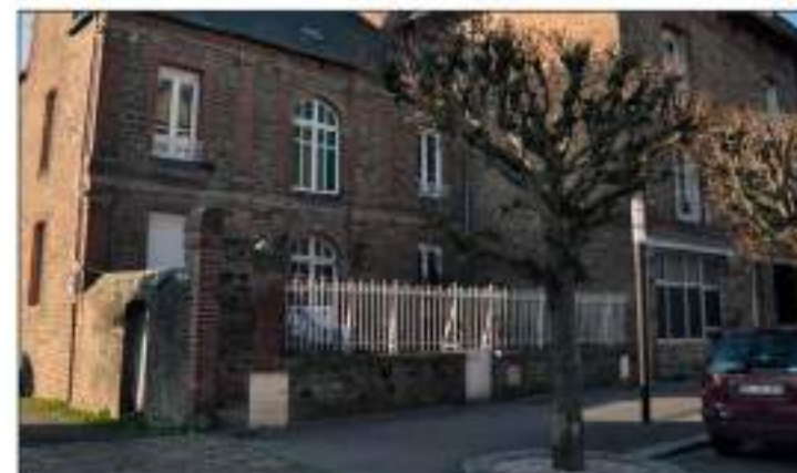
Fig. 95 : Mur plein et mur bahut Bd Planson
