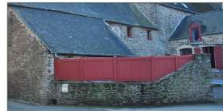
Fig. 98 : Muret rue de Paris
