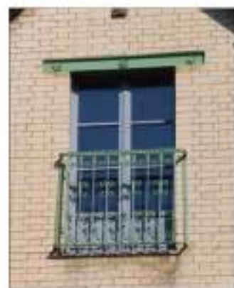
Fig. 359 : Garde-corps en fer forgé, 2 Grande-Rue des Stuarts
