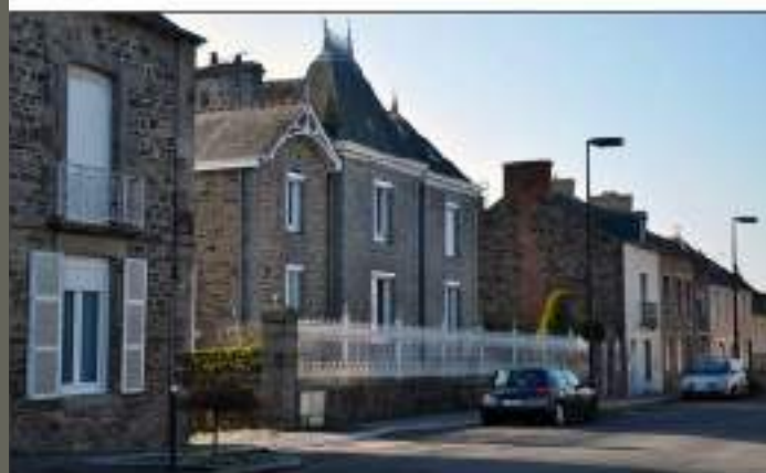
Fig. 91 : Mur bahut rue de Rennes
