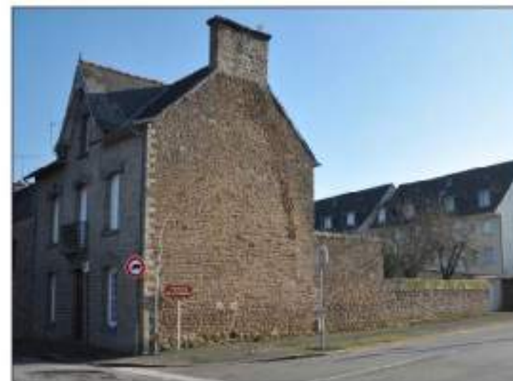
Fig. 96 : Haut mur, pignon et façade aveugle rue Aristide Le Braz
