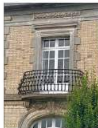
Fig. 344 : Garde-corps en fer forgé, 21 boulevard Deminiac
