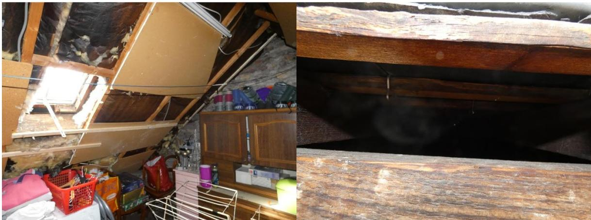
Figure 15 : Remise située dans les combles de la maison / Espace entre l'isolation et la toiture au niveau de la lucarne
