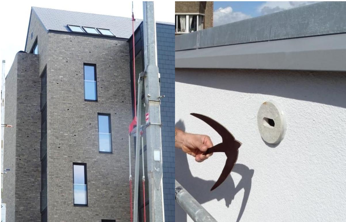
Figure 32 : Exemple de nichoirs encastrés dans la maçonnerie, à Visé et Bruxelles en Belgique - © Martine Wauters
