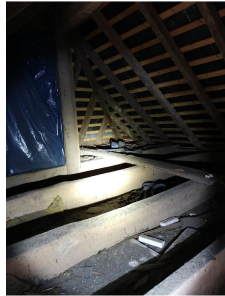
Figure 15 : photographies des combles investigués dans les différents bâtiments - iao senn 2022-2023
