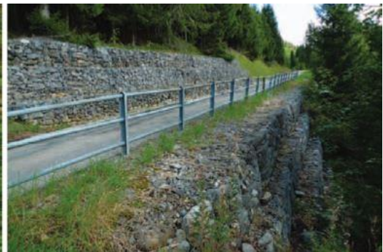
Figure 18 Gabions le long de routes (©karch Centre de coordination pour la protection des amphibiens et des reptiles de Suisse)
