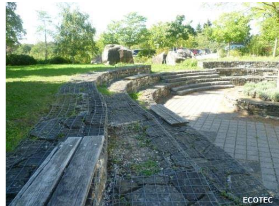
Figure 17 Exemples de gabions comme murs de soutènement et aménagement paysagers
