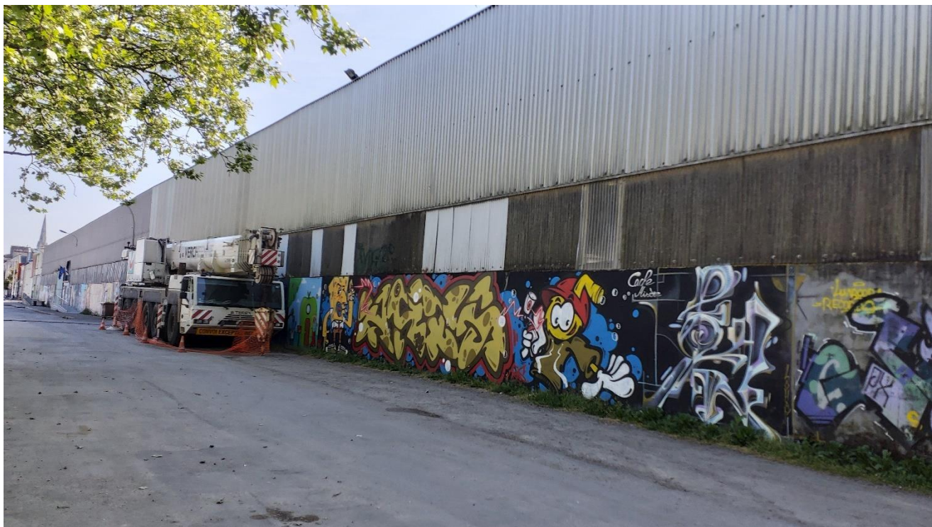
Figure 3. Aperçu du bâtiment (ancienne usine) (© Biotope, 2022)
