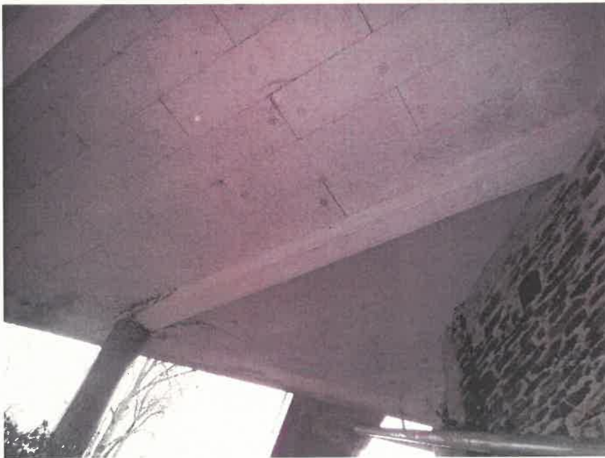
Le bâtiment est isolé extérieurement par un isolant en panneau polystyrène + fibre type Fibralth.
