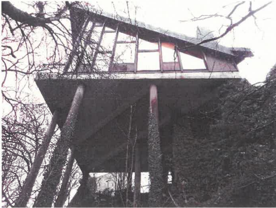
Vue du système poteaux/poutres
