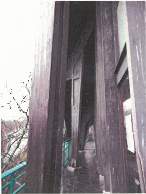
Des poteaux en bois massif et lamellé-collé composent la charpente.
