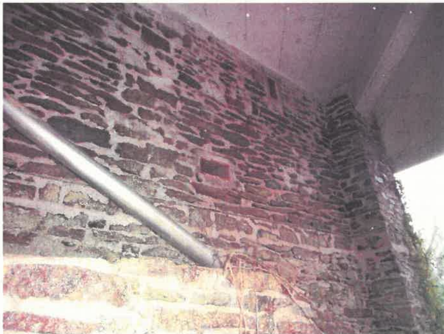
Sous face plancher bas du restaurant
