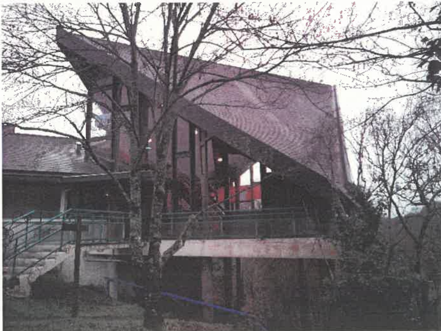
La toiture est une couverture ardoise sur liteaux.
