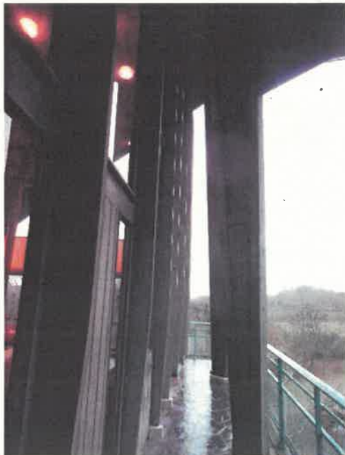
Une coursive contourne une partie du bâtiment sur les façades Nord et Est. Elle est constituée d'une chape sur laquelle repose des dalles ardoise.
