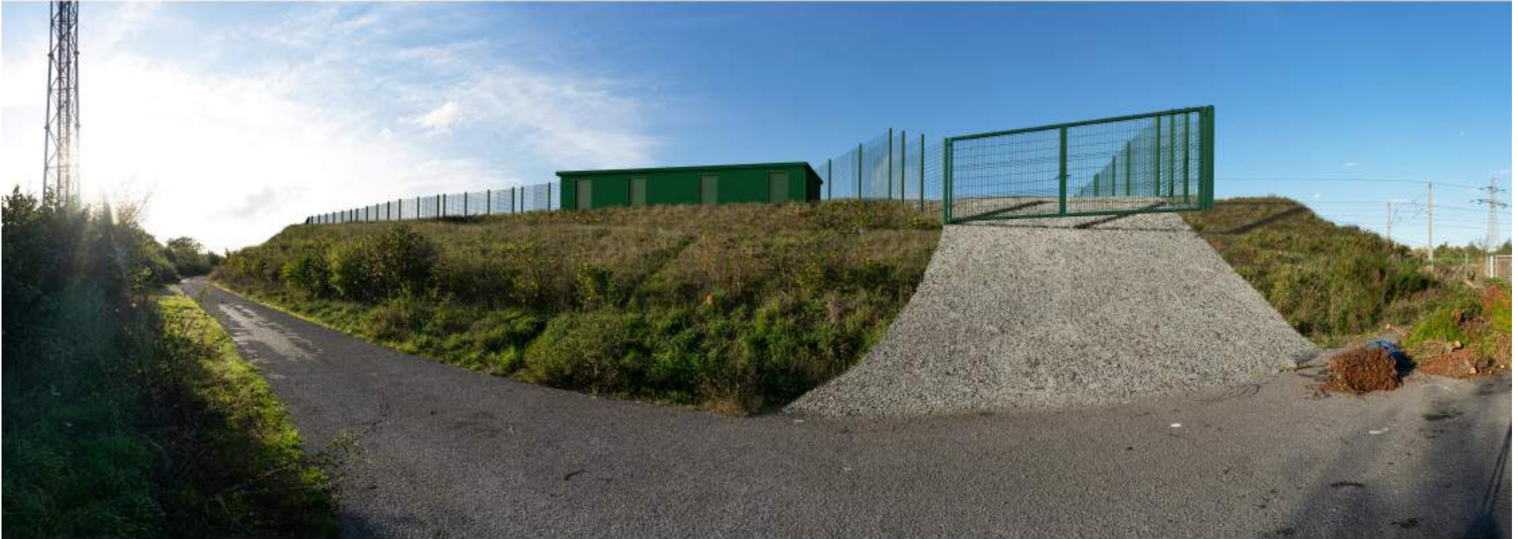
PV 4 : Depuis l'accès à la centrale photovoltaïque
