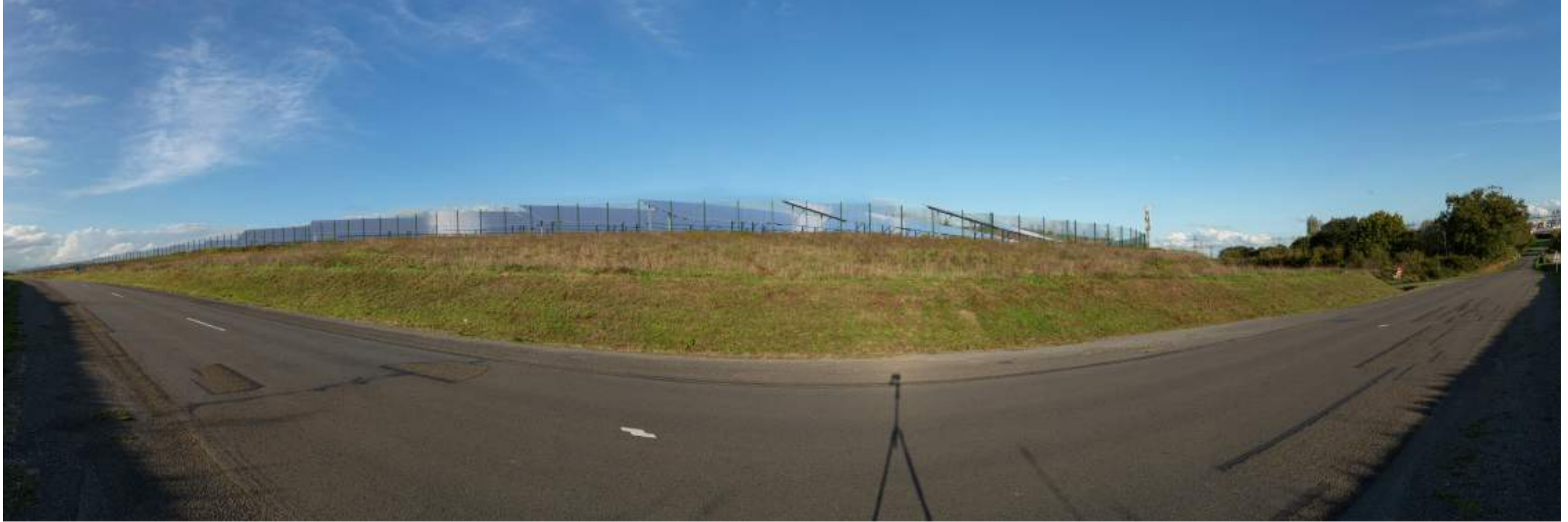
PV 3 : Depuis la RD 32 (sans mesures paysagères)
