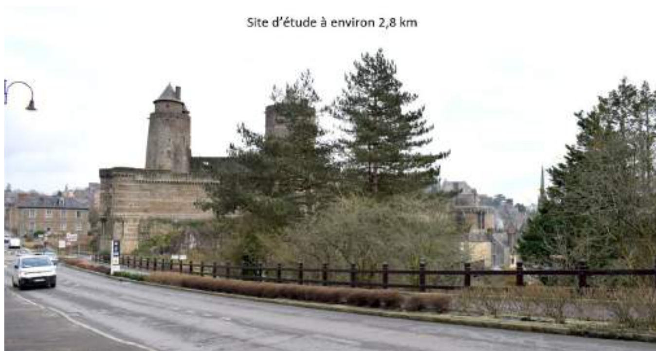
Cliché 27 : Depuis le boulevard Jacques Fauchoux, à proximité du château et de l'église Saint-Sulpice - la vue est totalement fermée en direction du site d'étude par la topographie encaissée de la vallée du Nançon (ville basse) - Sensibilité nulle.
