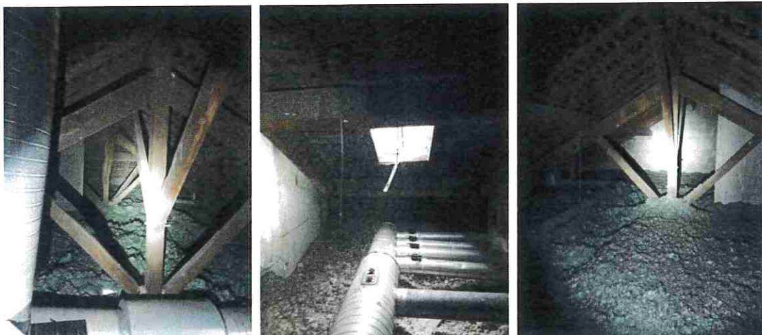
Combles du 103 boulevard Georges Clémenceau © LPO Bretagne
