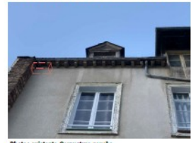
Photos existants-Couverture gauche
