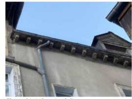
Photos existants-Couverture droit
