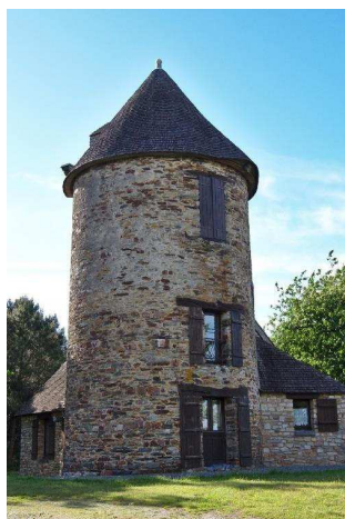
Figure 54 : Élément bâti à protéger du PLUi de Bretagne Porte de Loire Communauté : Moulin de Pomméniac
