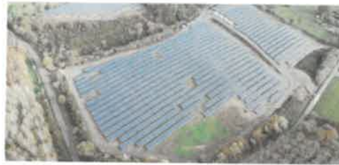
La centrale solaire de Guignen à laquelle pourrait ressembler celle de Javené. SOL35
