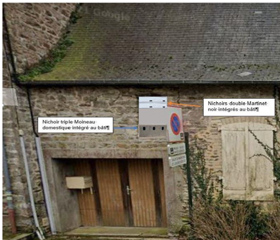
Façade Nord bâtiment 1D
