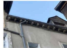
Photos existants-Couverture droit
