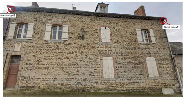
Façade Nord bâtiment 1B
