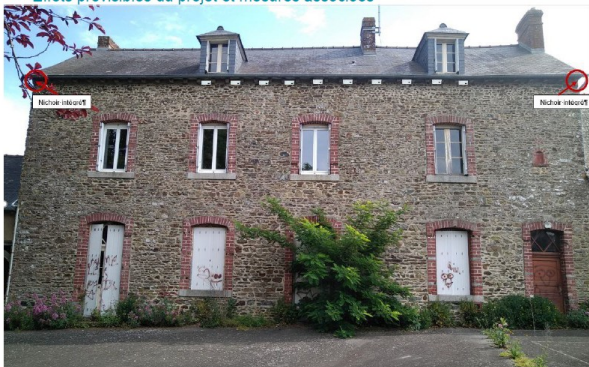
Façade Sud bâtiment 1B
