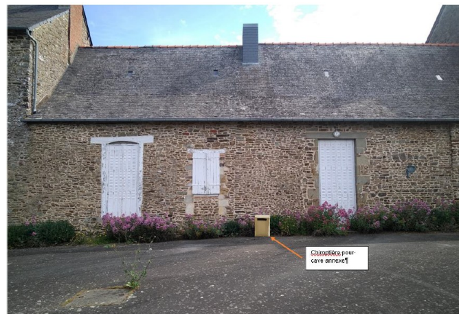
Accès chiroptères bâtiment 1C
