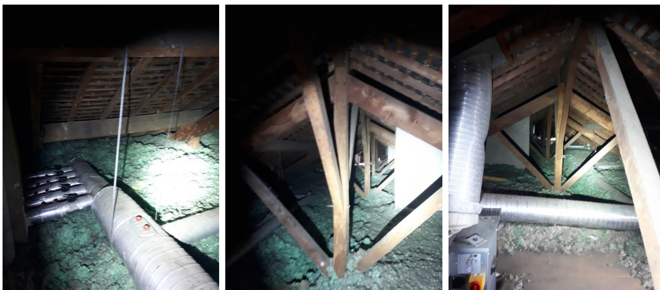
Combles du 117-119-121 rue de l'Alma © LPO Bretagne
