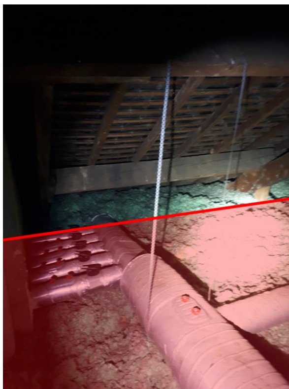
Isolant ajouté dans les combles du 117-119-121 rue de l’Alma (en rouge) © LPO Bretagne
