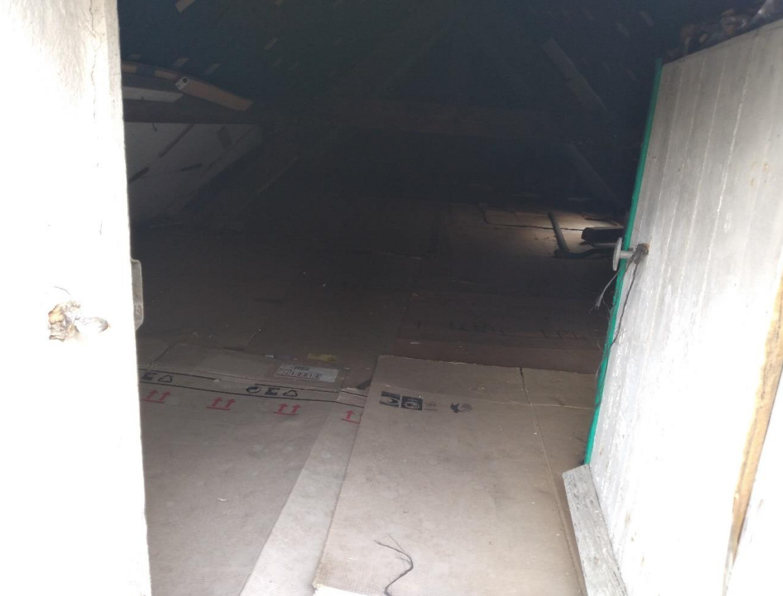
Figure 10 : Grenier ayant fait l'objet d'une inspection à la recherche de chiroptères
