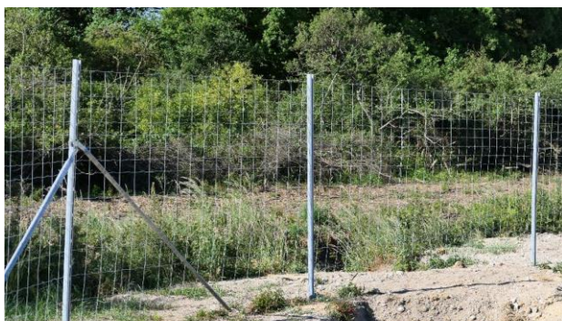
Figure 14: Clôture à mailles progressives à Argent-sur-Sauldre (18)
