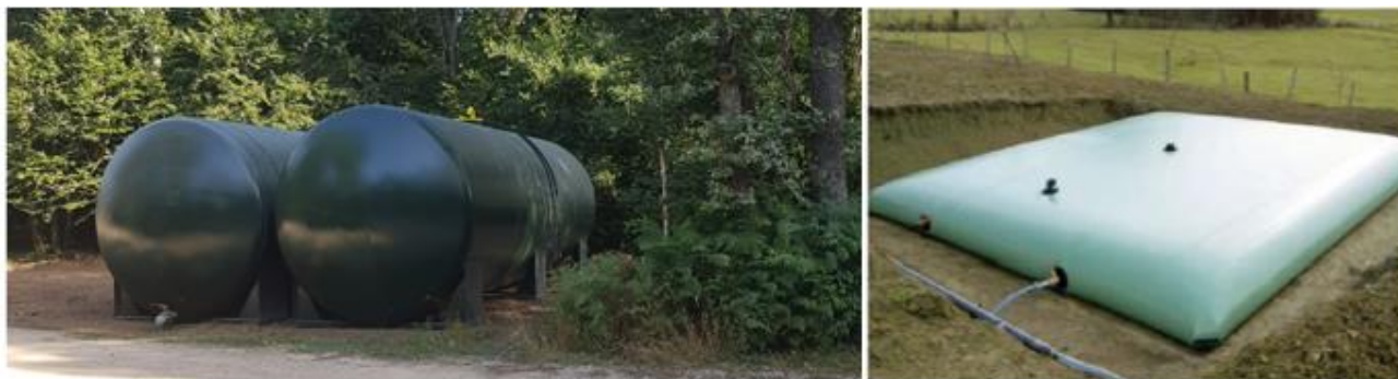
Figure 12: Exemple de réserves d'eau artificielles métalliques (à gauche) et souple (à droite)
