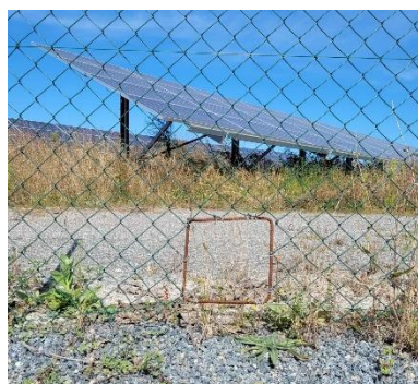
Figure 13: Passage faune à Exideuil (16)
