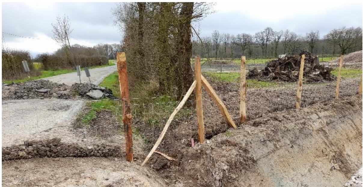
Figure 75 : Illustration de mise en défens en phase chantier
