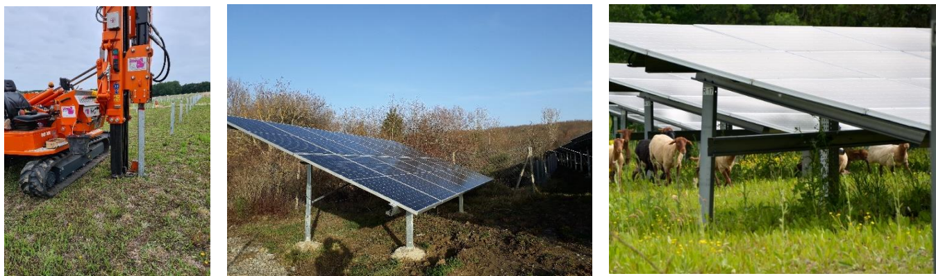
Figure 17: Exemple de pieux forés bétonnés et battus
