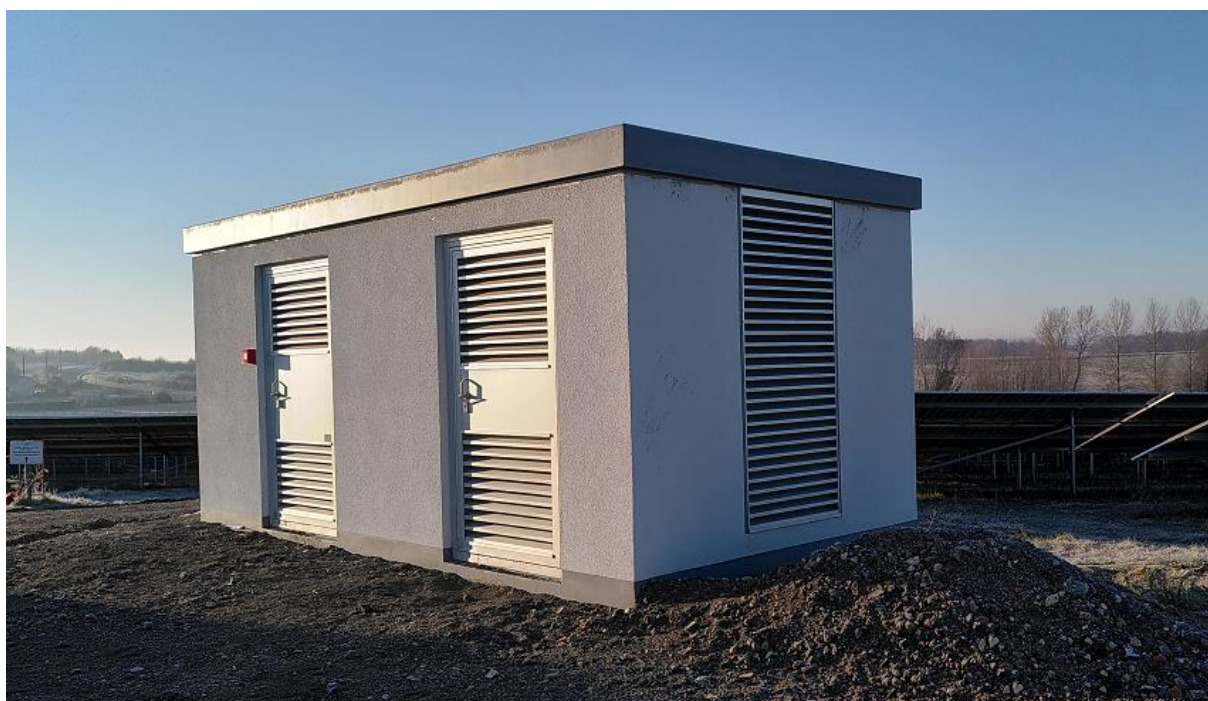
Figure 10: Poste de transformation remblayé
