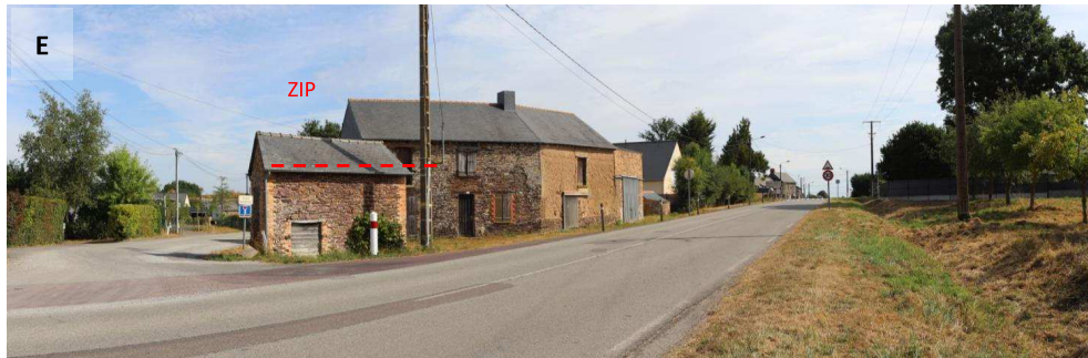
Photo 20 : Depuis le hameau de Barrière, le bâti le long de la route de desserte bloque les vues vers le site de projet
