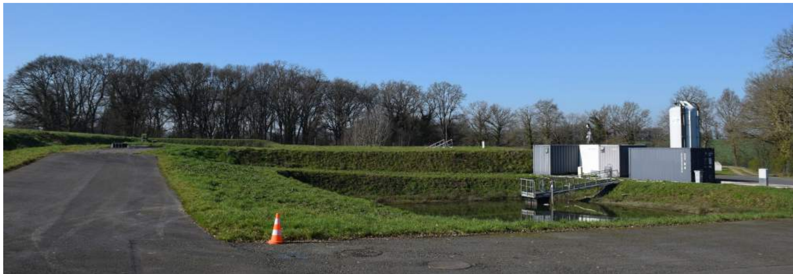
Figure 22 : Panorama du point n°6 de la zone d'implantation potentielle
