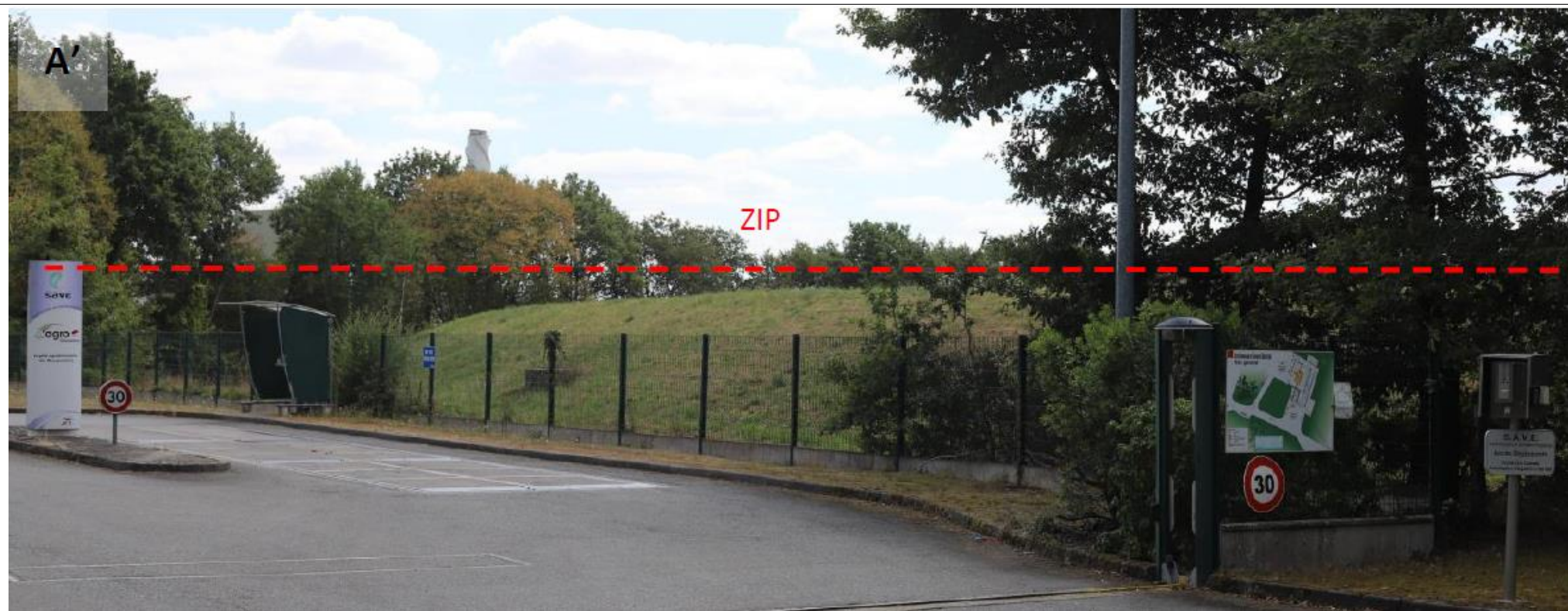
Vue depuis le nord-ouest du site au niveau de l'accès nord de l'usine de traitement des déchets.
