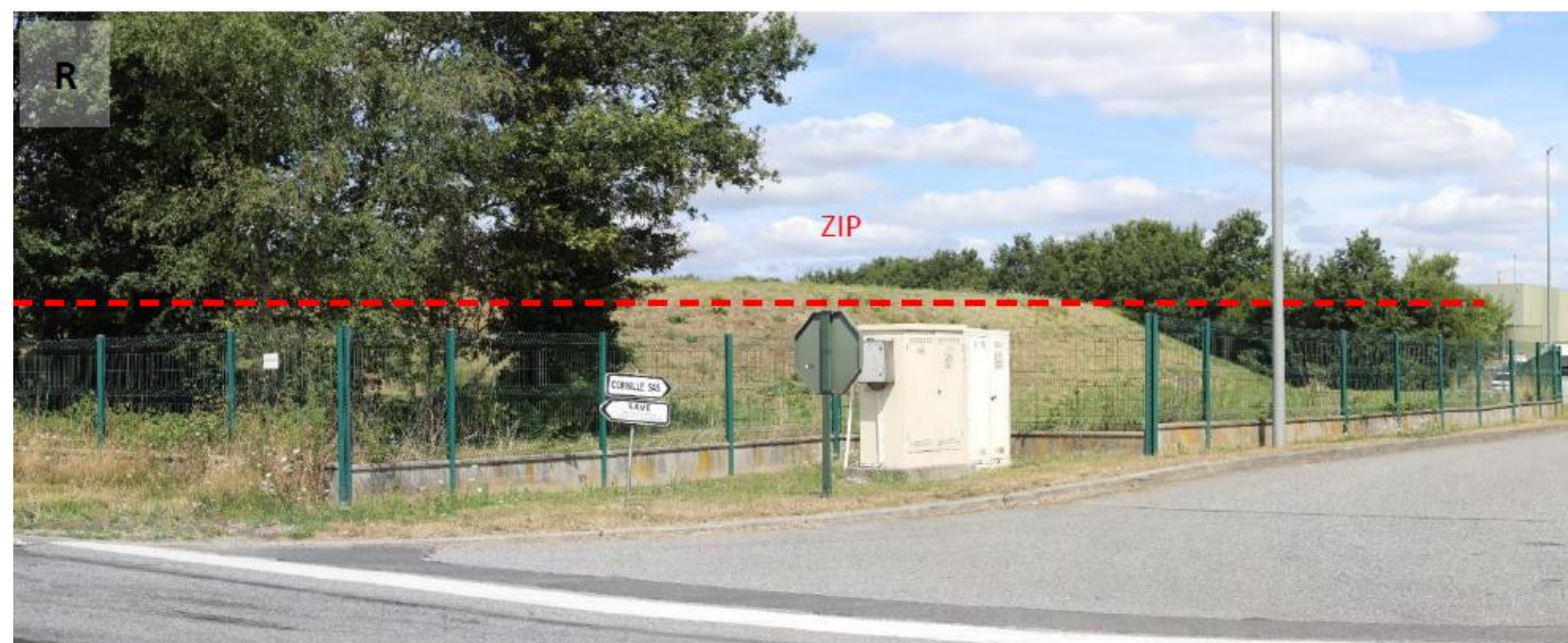
Vue depuis le sud-est du site du projet, depuis la RD 104 à proximité immédiate.
