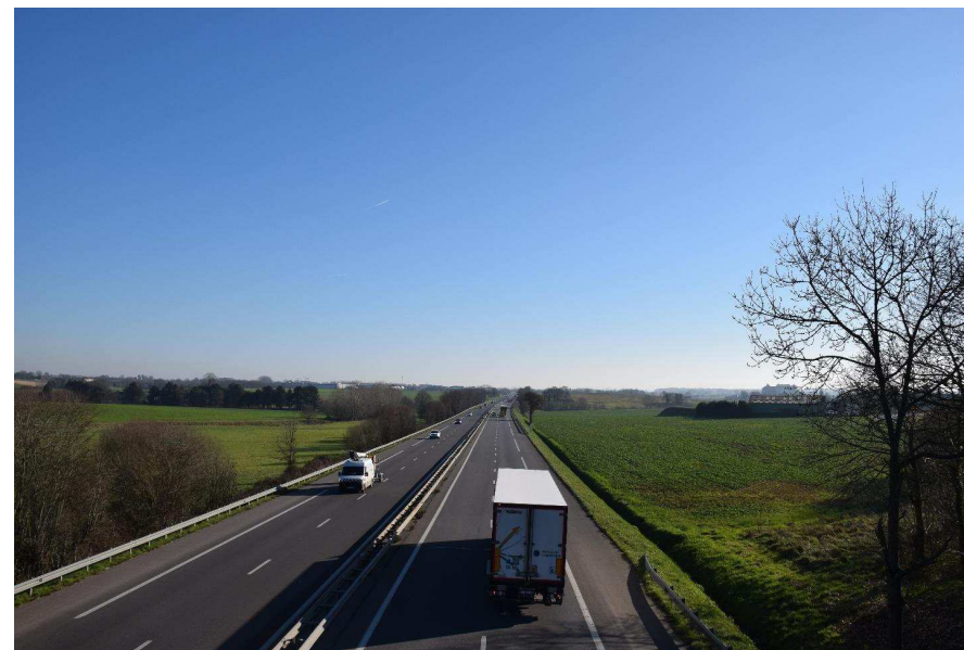
Figure 66 : Route nationale 157 (source : ATER Environnement, 2023)
