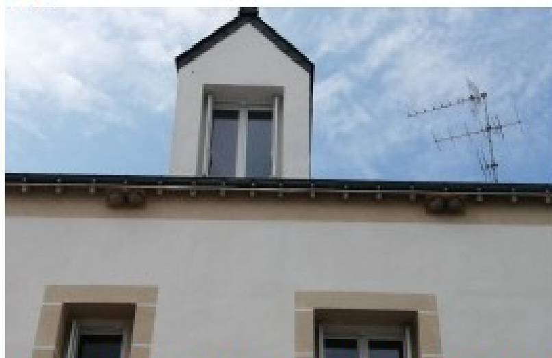
Bandes rugueuses sous avancées de toit favorisant la construction de nids naturels avec nids artificiels doubles © LPO Bretagne
