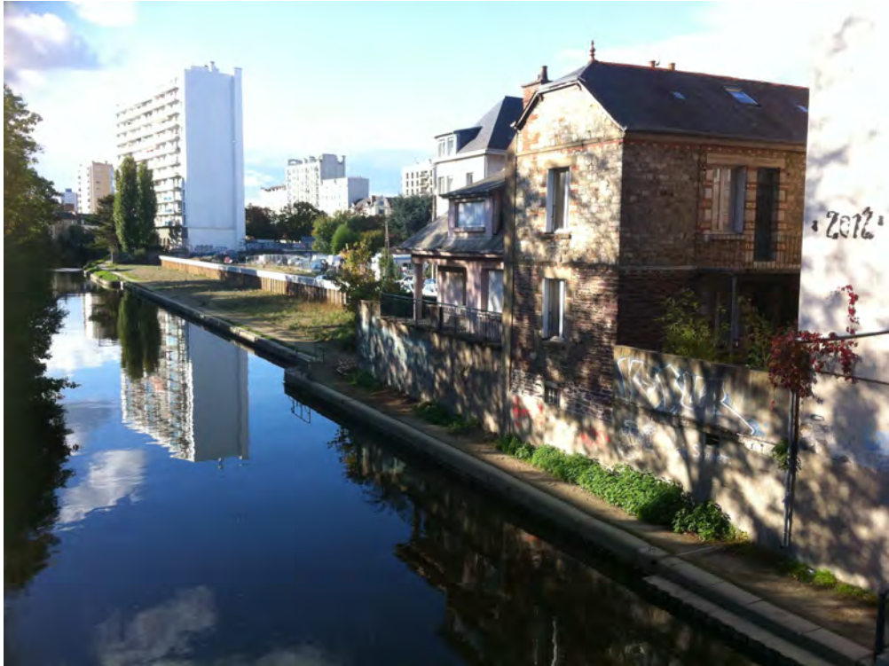
Vue générale sur les murs
