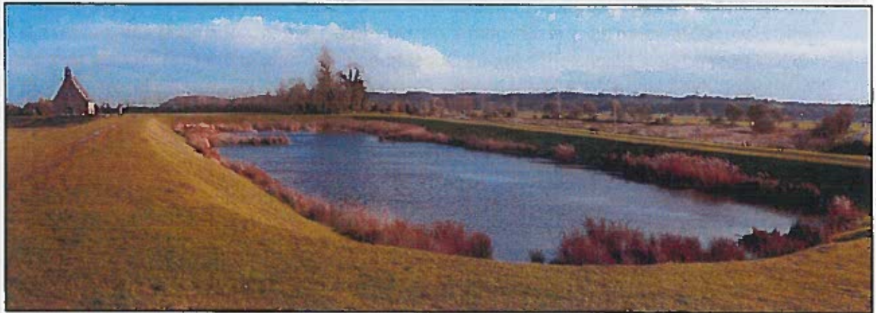
Figure 12 : Tronçon continental de la digue de la Duchesse Anne (au niveau de la chapelle Sainte-Anne)
