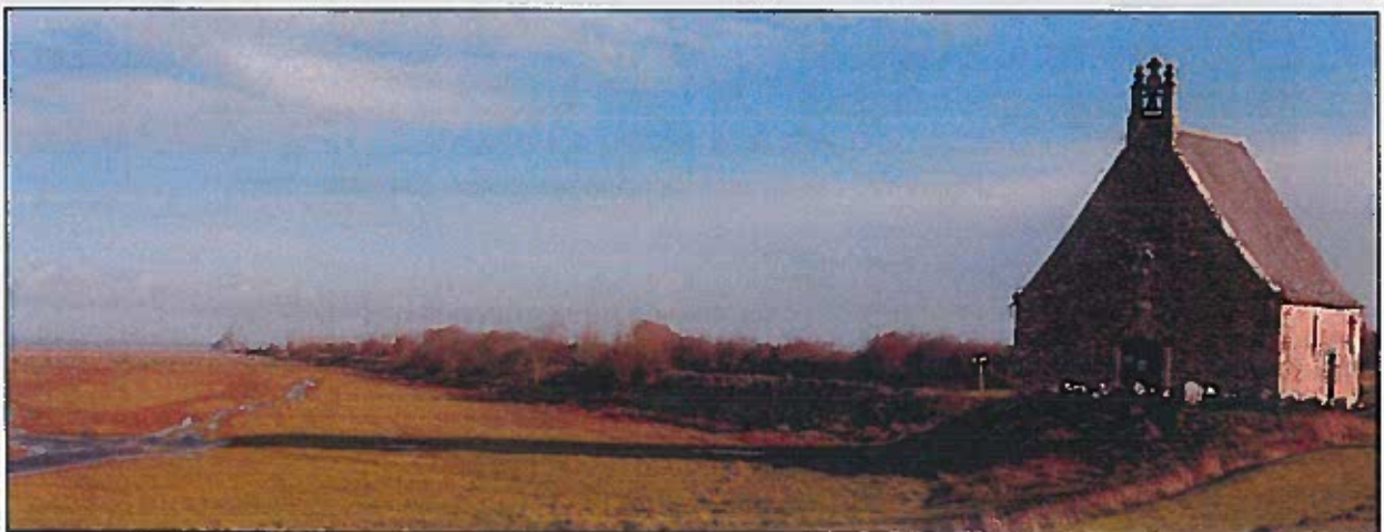
Figure 13 : Digue de l'Ouest (au niveau de la chapelle Sainte-Anne)
