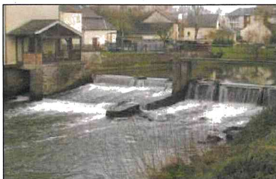
Ouvrages lors de la visite (20/01/2012)
