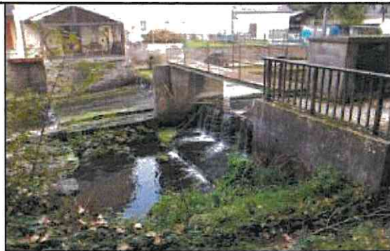
Ouvrages en étiage (03/09/2011)
