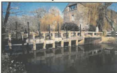
Ouvrages A et B vue de l'amont
