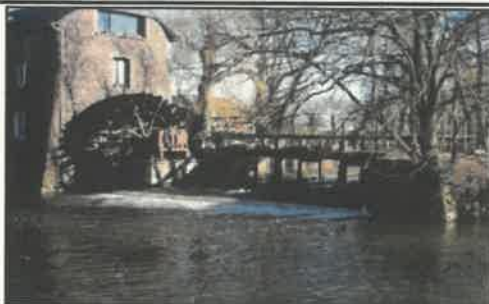
Ouvrages A et B vue de l'aval
