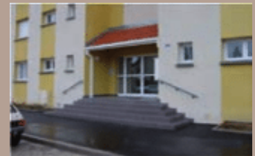
Un bâtiment inaccessible aux personnes à mobilité réduite
