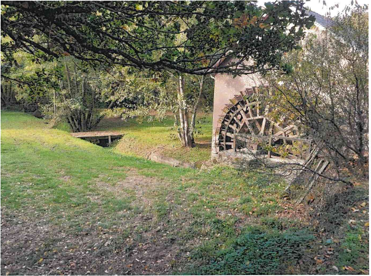
Vue sur le canal usinier (partie aval – rive droite)
